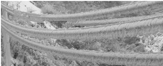
图 14 融冰前分裂导线上的覆冰情况
