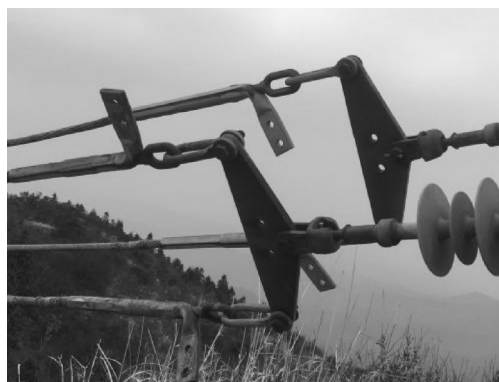
图4 分裂导线端部的连接方式
